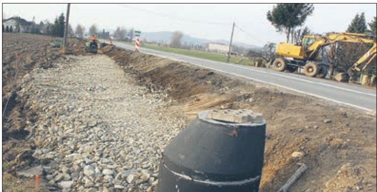
Ruszyła budowa ciągu pieszo-rowerowego w Faściszowej
