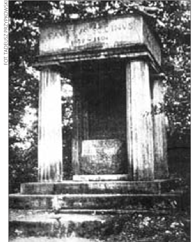
Mauzoleum wybudowane w 1936 r. według projektu Adolfa Szyszko - Bohusza na terenie parku dworskiego w Lusławicach
